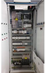
Les parafoudres de type II en place seront remplacés directement par du type I+II ou coordonnés à des nouveaux parafoudres de type I (coordonnés en cas de marque similaire).
